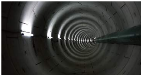
放水トンネル
