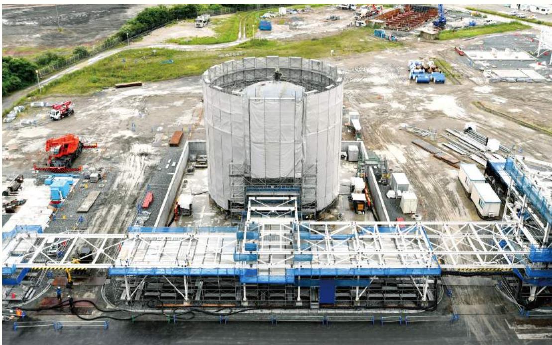
碧南火力発電所で建設中のアンモニア貯蔵タンク
