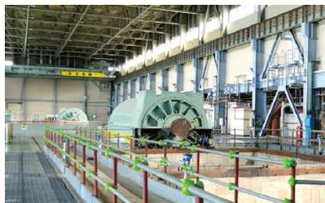
廃止措置中の1・2号機タービン建屋内
