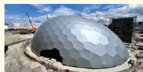
建設中の電力館
