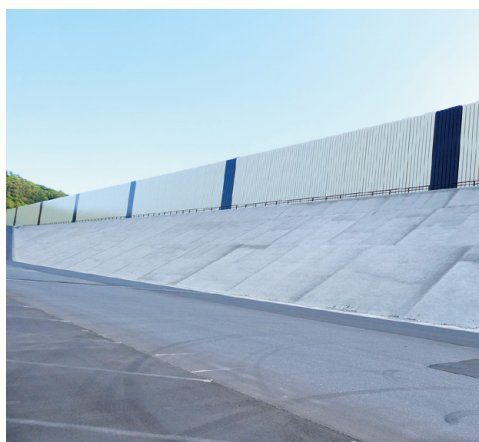
海拔29m、全長約800mの女川原子力発電所防潮堤
