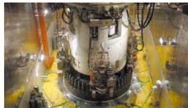
原子炉圧力容器上蓋の取り付け作業
