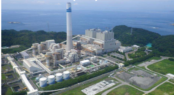
松島火力発電所(現在) 長崎県西海市
