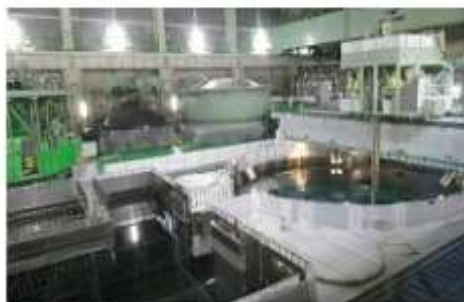
燃料装荷（写真は原子炉に燃料集合体を挿入する作業の様子）
