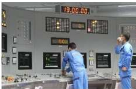
原子炉起動操作（写真は原子炉モードスイッチを「起動」に切り替える様子）
