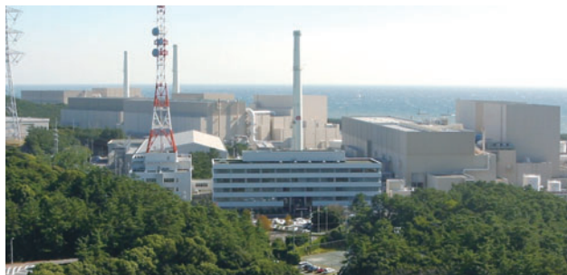
中部電力(株)浜岡原子力発電所
