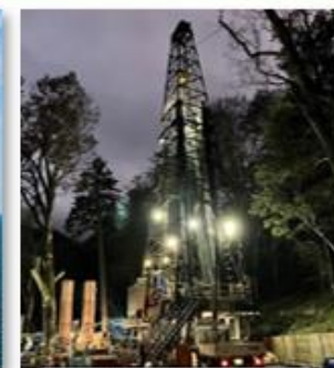
調査井掘削状況 (地熱)
