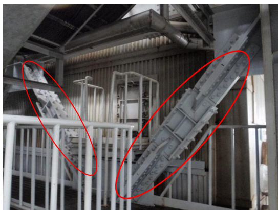
ボイラ支持架構の補強例
