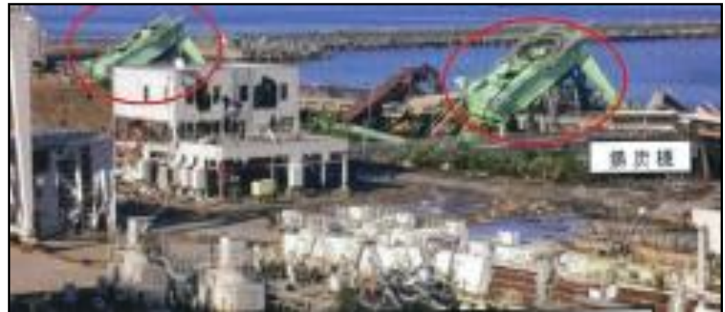
(写真4) 揚炭設備の被害
