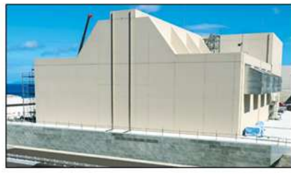
図2 乾式貯蔵建屋の外観
