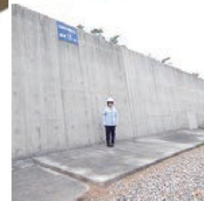
防波壁や防潮堤の設置
