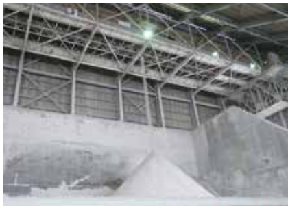
火力発電所の排煙脱硫装置から取り出した石こう(副生品)
