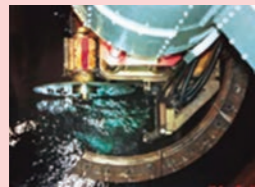
原子炉の解体
