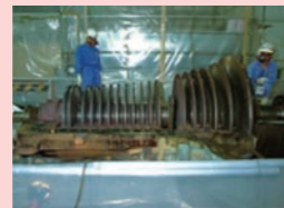
周辺設備の解体
