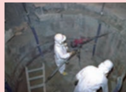
原子炉の周囲にある施設の解体
