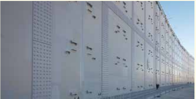
防波壁（中部電力）
