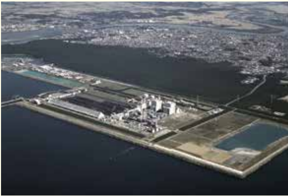
能代火力発電所 (東北電力)
