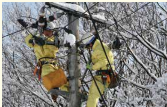
豪雪被害からの懸命の復旧作業（北陸電力）
