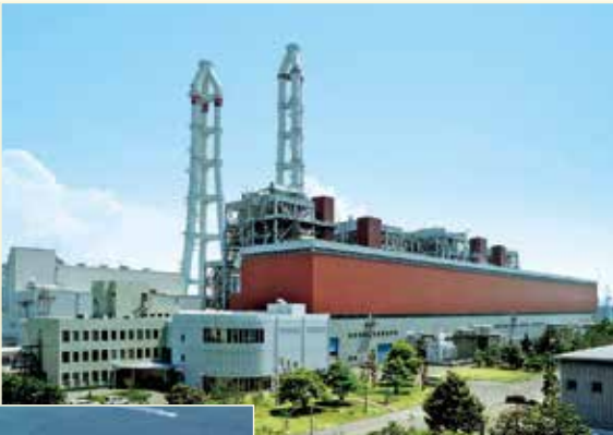
坂出発電所(四国電力)
