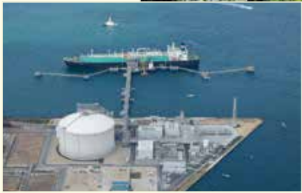
坂出LNG基地
