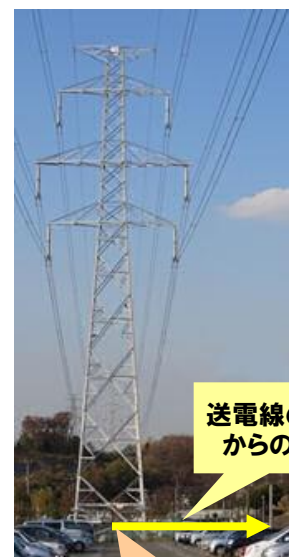
送電線の中心
