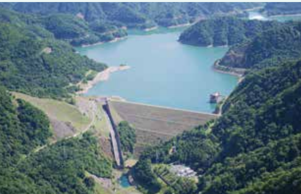
高見水力発電所 提供：北海道電力
