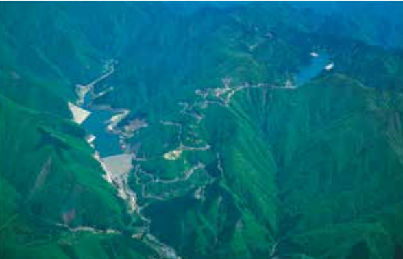
奥美濃水力発電所 提供：中部電力
