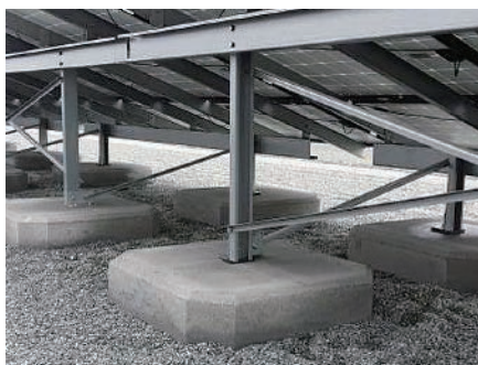
コンクリート内への固定(CO 2 -SUICOM) (2022年度研究開発完了) 提供: 中国電力株式会社
