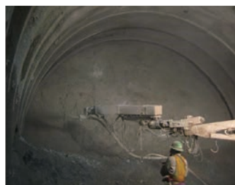
石炭灰を使用した吹付けコンクリート (トンネル施工状況) 提供：北海道電力株式会社
