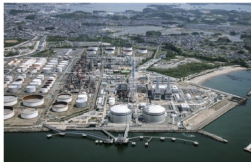
新仙台火力発電所
