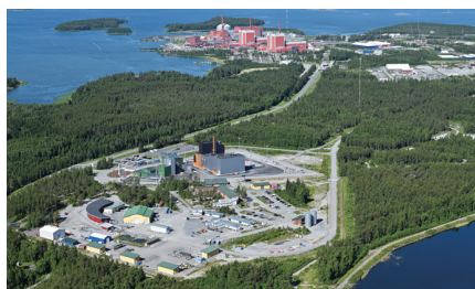
フィンランド・オルキオトの最終処分場 Photo Posiva Oy
