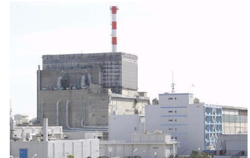
日本原子力発電 東海発電所
