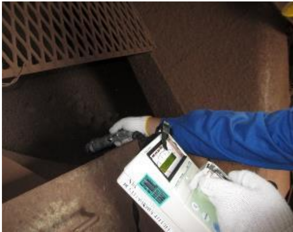
造粒ダスト(建屋集塵機)
