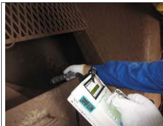
建屋集塵機造粒ダスト
